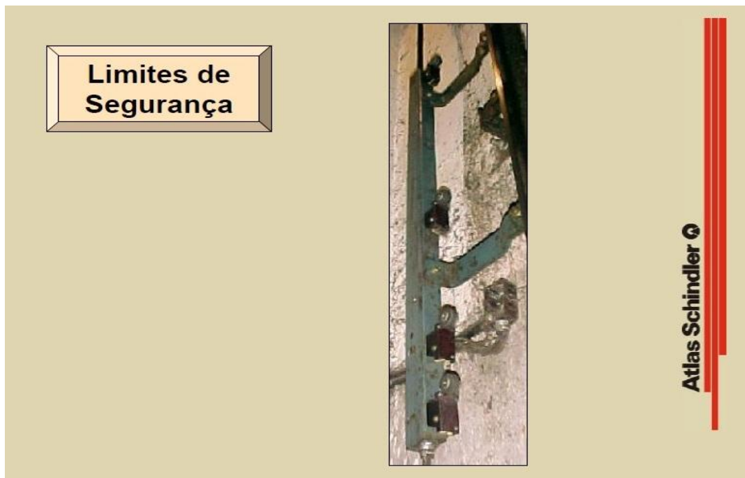
Figura 2-5 Chaves limitadoras fim de curso em elevadores [www.atlas.schindler.com]
