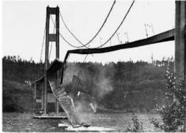
Figura 6-20 – O desastre da ponte do rio Tacoma poderia ter sido evitado pelo uso de modelos adequados.
